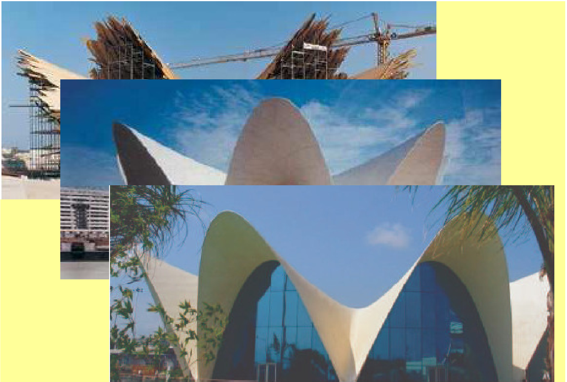
L'Oceanogràfic de la Ciutat de les Arts i de les Ciències de València, durante su construcción.
